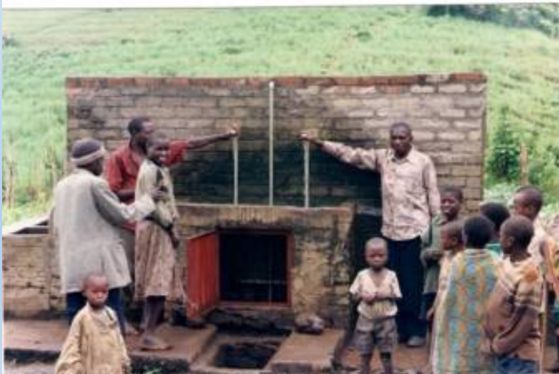
Ripristino di un acquedotto a Jomba, con lavatoio
