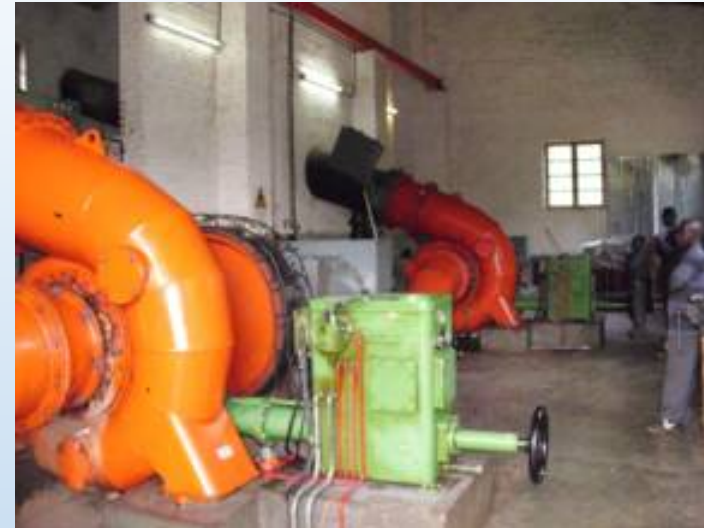
Centrale di Kyondo 320 kw
