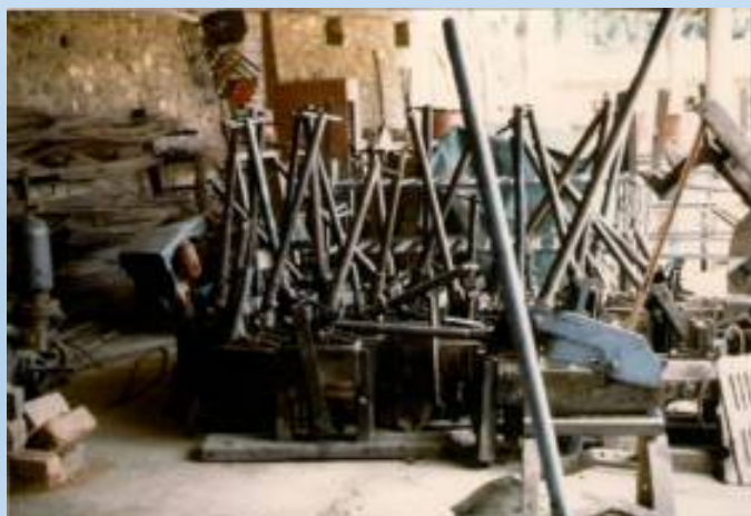
Presses per fabbricare mattoni costruite sul posto
