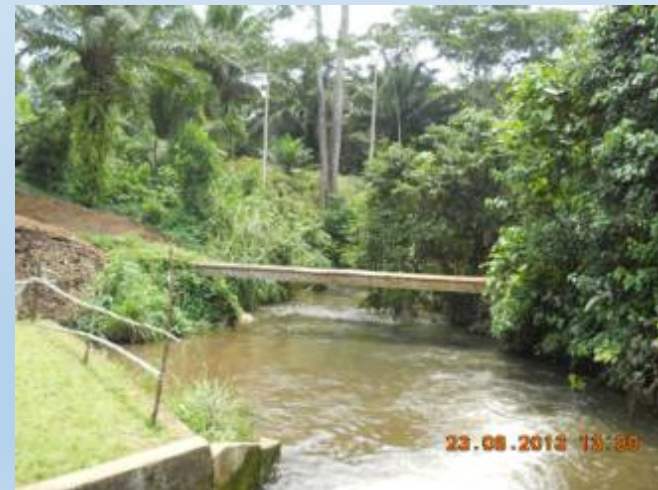
Costruiti almeno 20 ponti per pedoni e camionette, in putrelle di ferro
